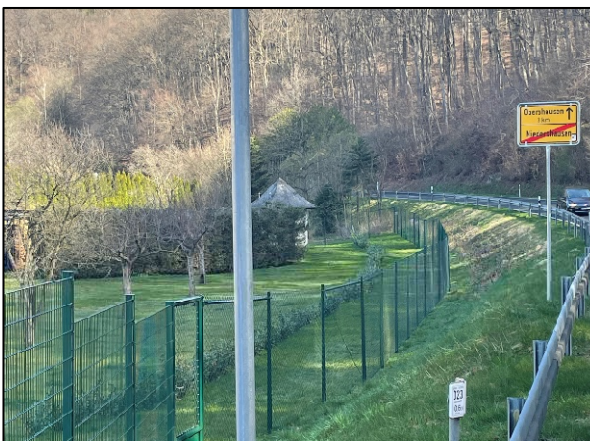
Abb. 7: Blick auf die Landesstraße
