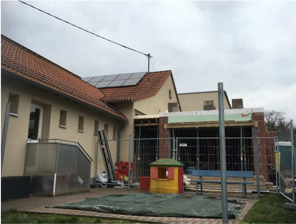
Anbau des neuen Gruppenraums
