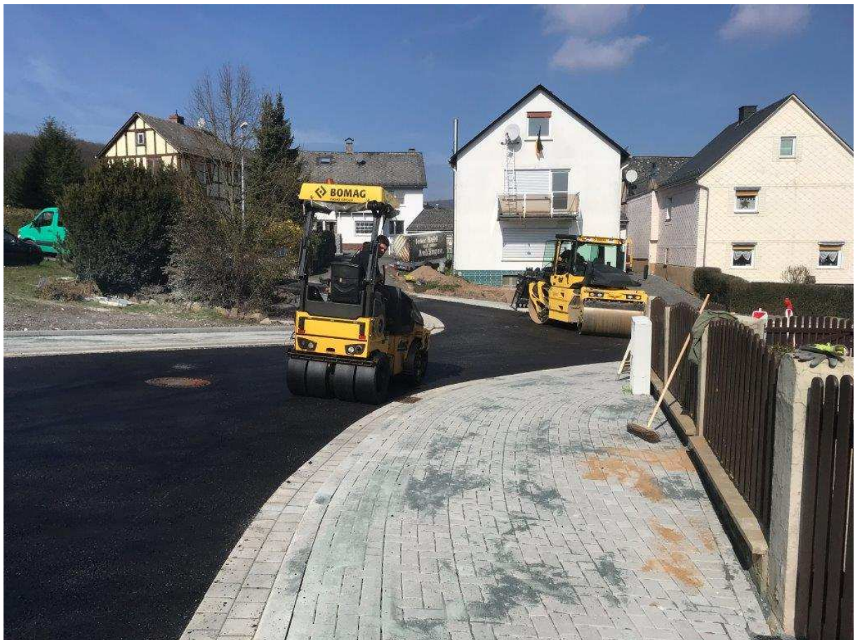
Sanierung Dillhäuser Straße in Oberhausen – Aufbringen der Tragschicht
