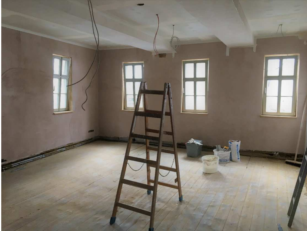
einer der zukünftigen Ruheräume im Obergeschoß
